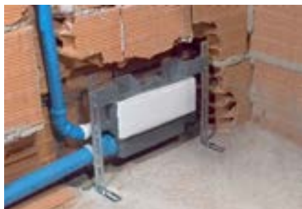
Aplicação em parede de alvenaria
